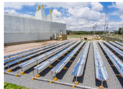
Sistema SHIP con colectores cilíndrico-parabólicos
